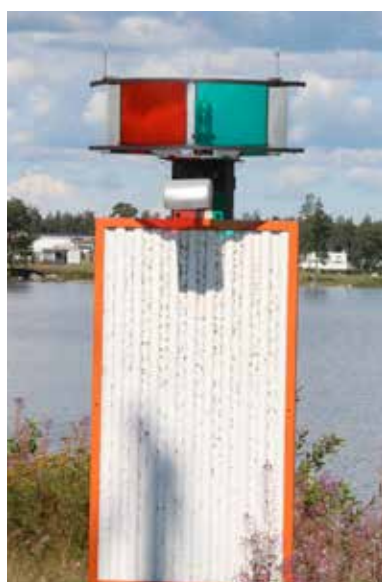
Fyrlykta och hållare med färgade glas på en liten hamnfyr.
