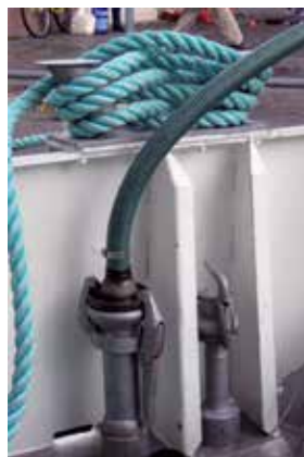
Toalettavfall töms till tank iland. Den andra anslutningen är till för att suga iland oljehaltigt slagvatten.
