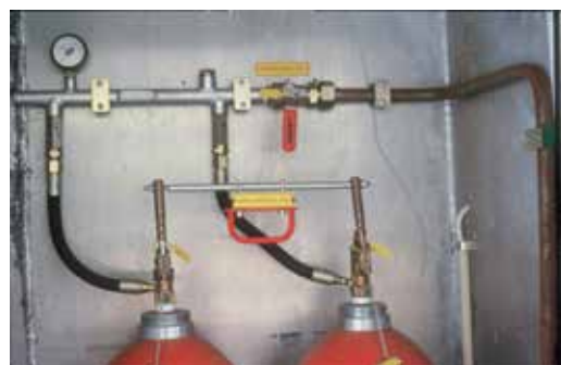
Utlösning av CO 2 -släckning för maskinrum, först kikkranen överst sedan greppet under.
