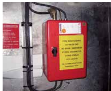
Utlösarenhet för halotron.
